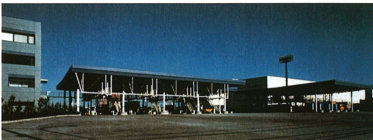
トラックゲート全景
