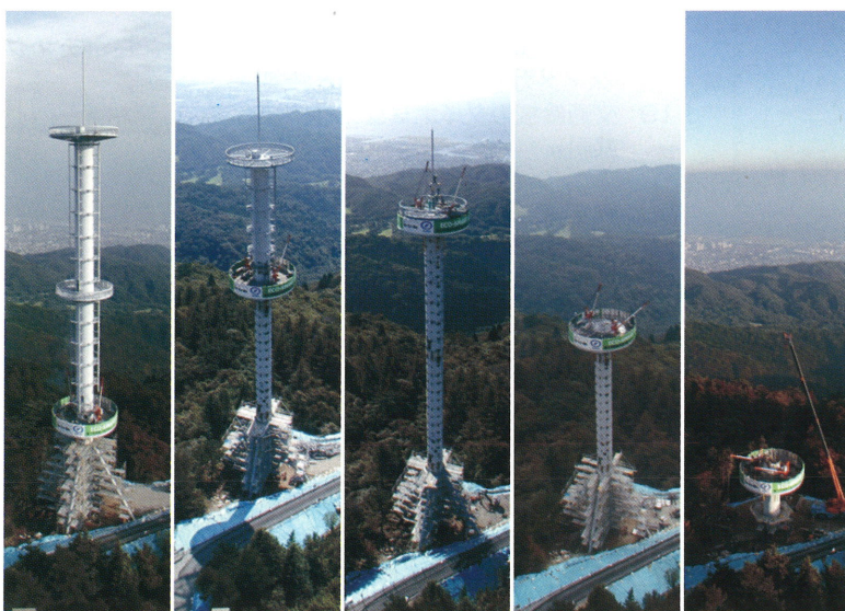
工事の進捗状況
