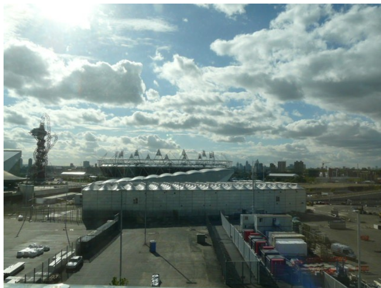
図7 オリンピックスタジアムと整備工事中の周辺の様子（2012年10月12日）
