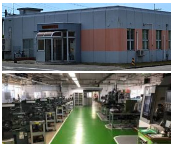
図5 情報処理センター（上）、実習工場（下）
